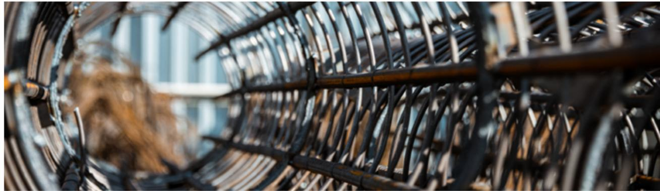
Компания «ДиПОС» освоила производство современных строительных конструкций – арматурных каркасов. Эта продукция применяется для армирования железобетонных опор крупных инфраструктурных объектов – мостов, эстакад, развязок автомобильных дорог и т.д. Такие решения позволяют увеличить прочность и устойчивость опор к нагрузкам продолжительного воздействия и предотвращать их разрушение.
