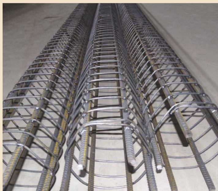
Буронабивные сваи – один из способов организации фундамента строящегося здания. Такого рода сваи применимы для строительства зданий любого назначения (жилого, общественного или производственного типа). Основанием для железобетонной буронабивной сваи являются гравийно-галечниковые отложения, пески и горные породы различных типов.
